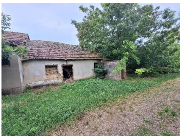
Zgrada br.2- pomoćna zgrada
